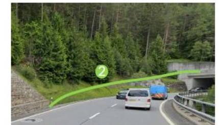
Bergseitige Rampe nördlich Sera
